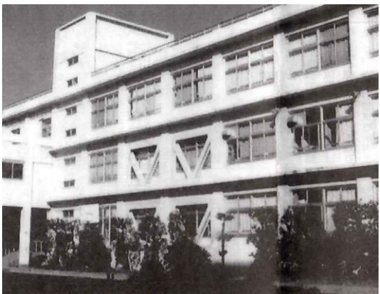
鉄骨ブレース装着校舎
